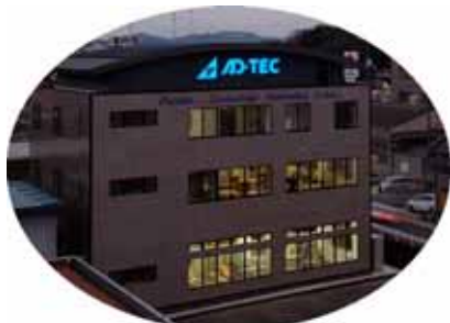
図1 イノベーションセンターの全景
