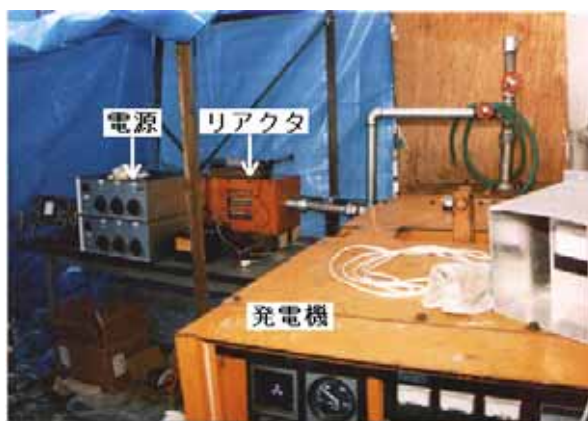
図5 ディーゼル発電機の排ガス処理の様子
