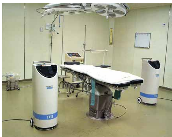
図1 オゾン殺菌装置の設置例
