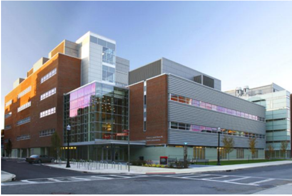
写真2 東西2館からなる機械・航空工学科ビル
