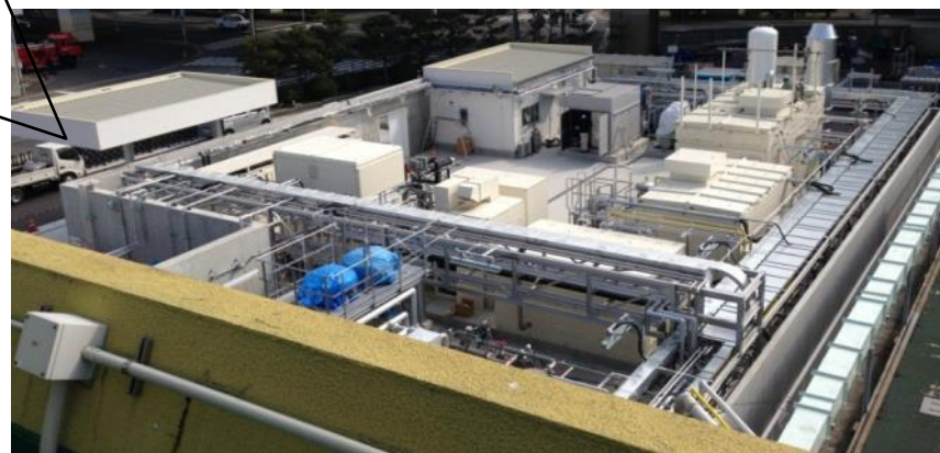
水素製造施設全景
