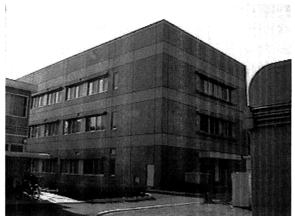
図1 次世代光基盤研究センター
