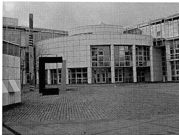
図2 MPIP 正面からの写真。MPIP に所属するスタッフや学生は皆, 電子キーをもち, 中に入るときはどの扉もこのキーでのみ開けることができる。またキーは研究所内の安全講習を受けたものでないと受け取るできない。建物の壁はほとんどがガラス張りになっている。曇って太陽のあまり見えない冬でも少しでも明るい状態にするためかと思われる。
