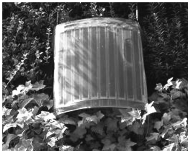
図5 愛知万博の垂直緑化壁「バイオラング」の曲面に設置した色素増感太陽電池モジュール。正面から見て左側より直射光があり、右側は影となっている。（巻頭カラー口絵参照）
