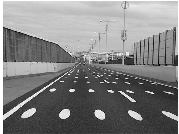
図3 オプティカル・ドット (首都高速埼玉大宮線美女木ジャンクション付近)<sup>5)</sup>。(資料提供：(株)ステュディオ・ハン・デザイン, 写真：櫻井ただひさ)
