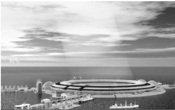
図5 L-SSPSの洋上受光基地の構想図。1GWのパワーで受光エリアは300m程度。
