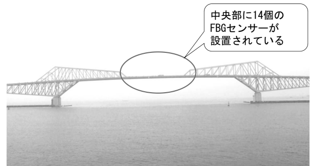
図9 FBG センサーを設置した東京ゲートブリッジの概観.
