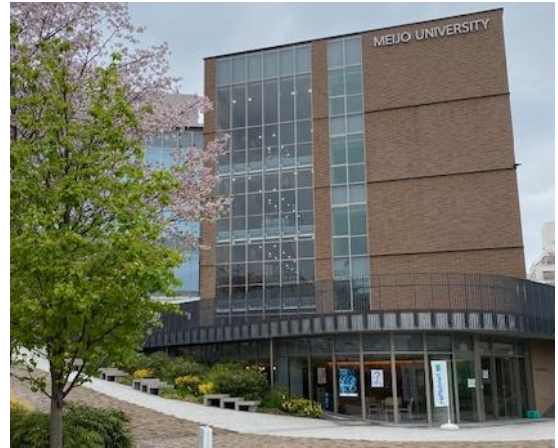
図 3. 電気電子工学科が入居している新設された研究実験棟 III の写真。
