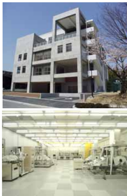
写真2．超精密科学研究センターの外観ならびにクラス1クリーンルーム内の様子
